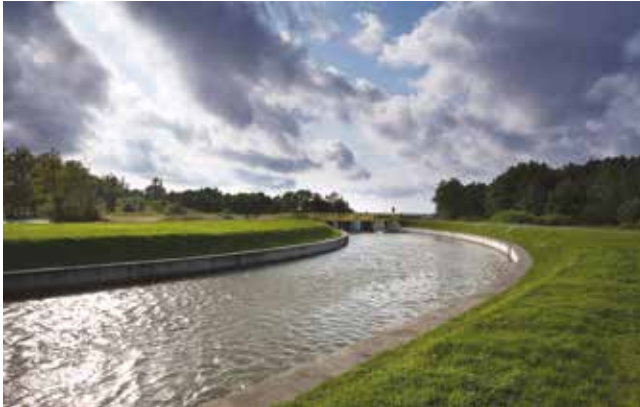
Wrota sztormowe Sturm Tore
